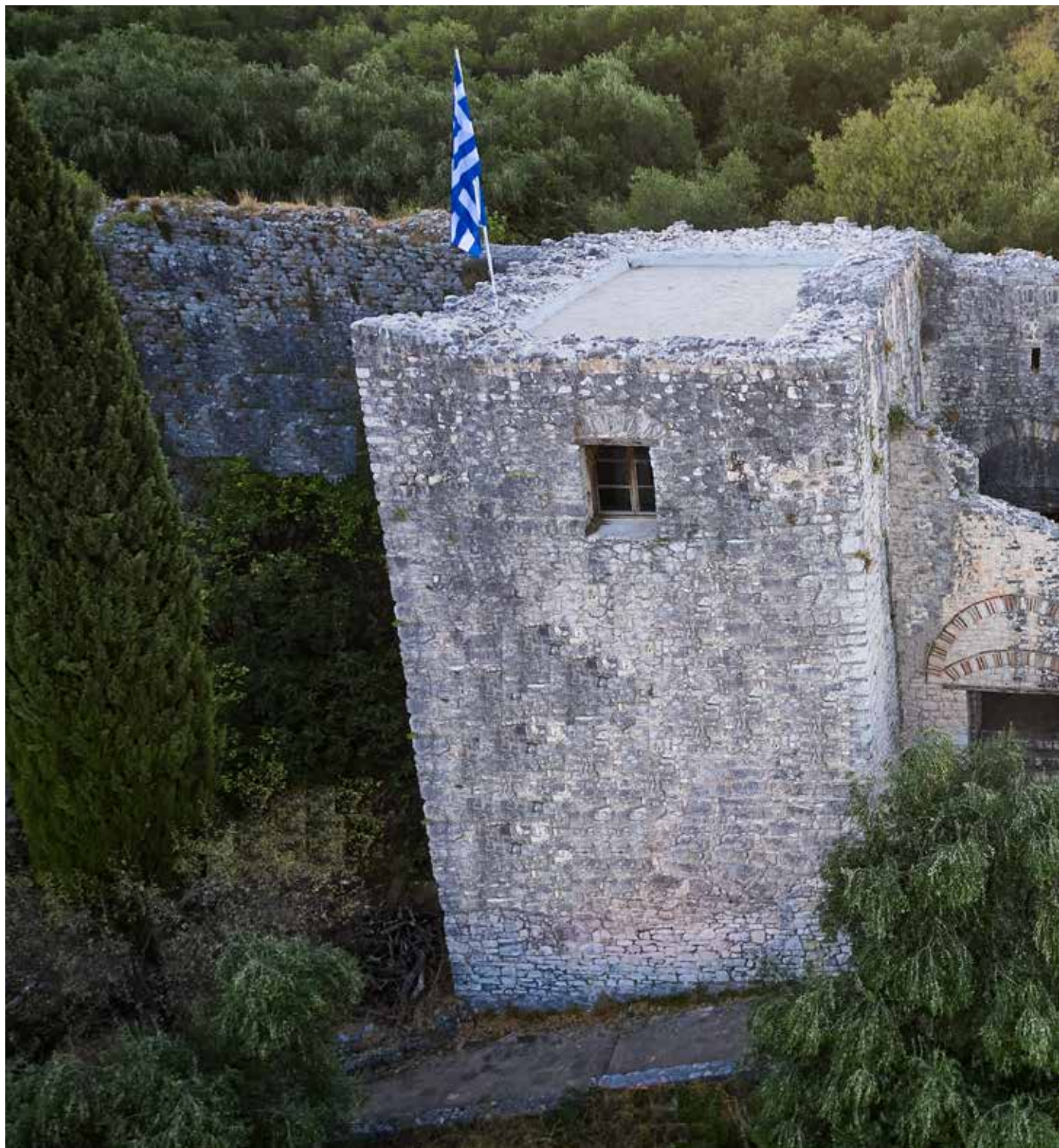
Άποψη της πύλης του κάστρου, Αρχείο ΕΦΑ Κέρκυρας
